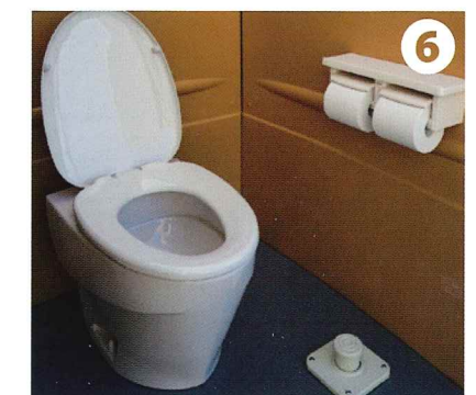
⑥ 洋式便器を取り付けます。次に足踏みポンプとペーパーホルダーを取り付けます。
